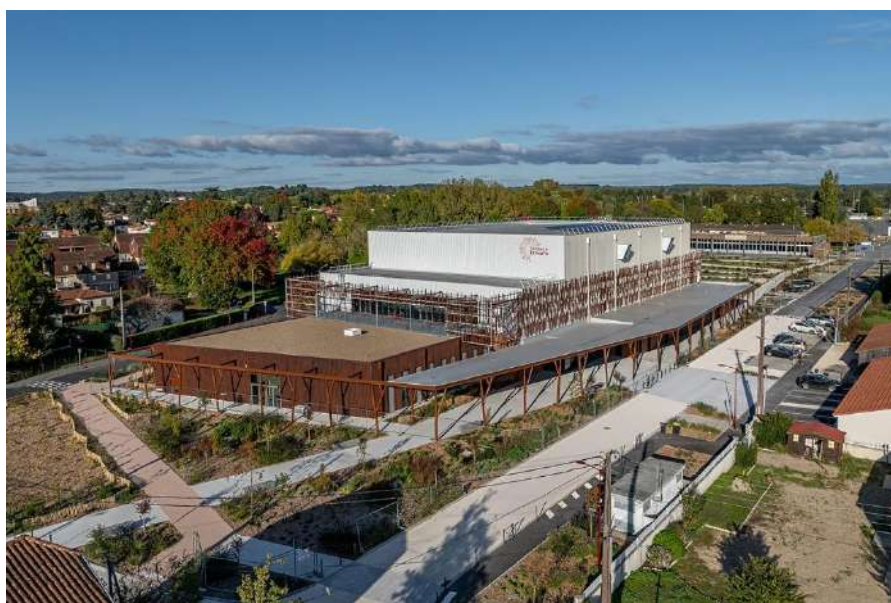
Figure 46 : Centre Etincelle - Source : https://la-cab.fr/
